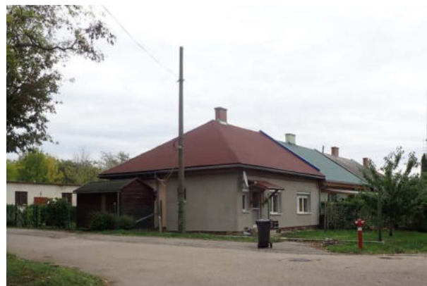
Hősök tere sorházas beépítési módú épületei (Forrás: saját fotó)
