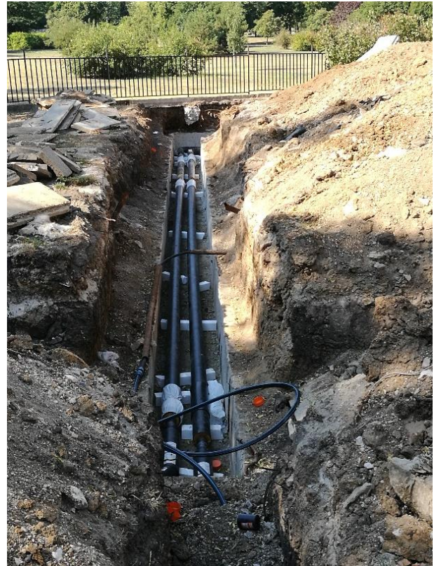
3. kép – távhővezeték építés az iskola udvarában
