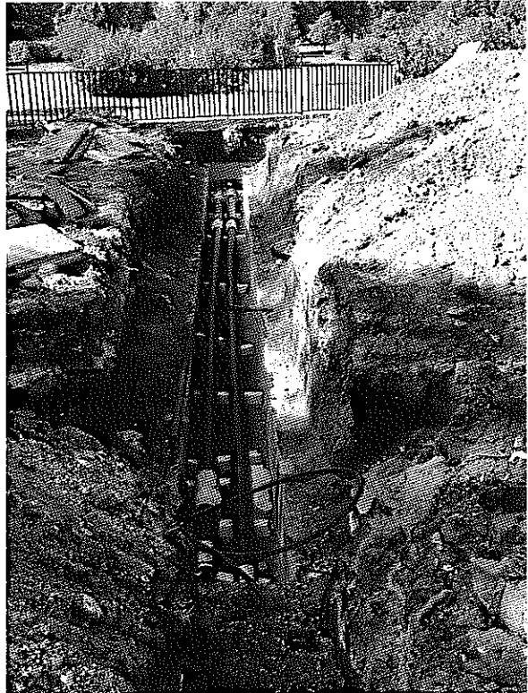
3. kép – távhővezeték építés az iskola udvarában
